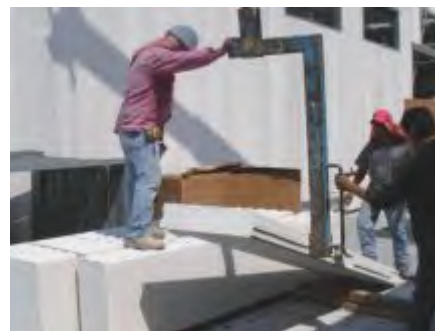
Fig. 15: Colocación del gancho G90 por el lado macho.
